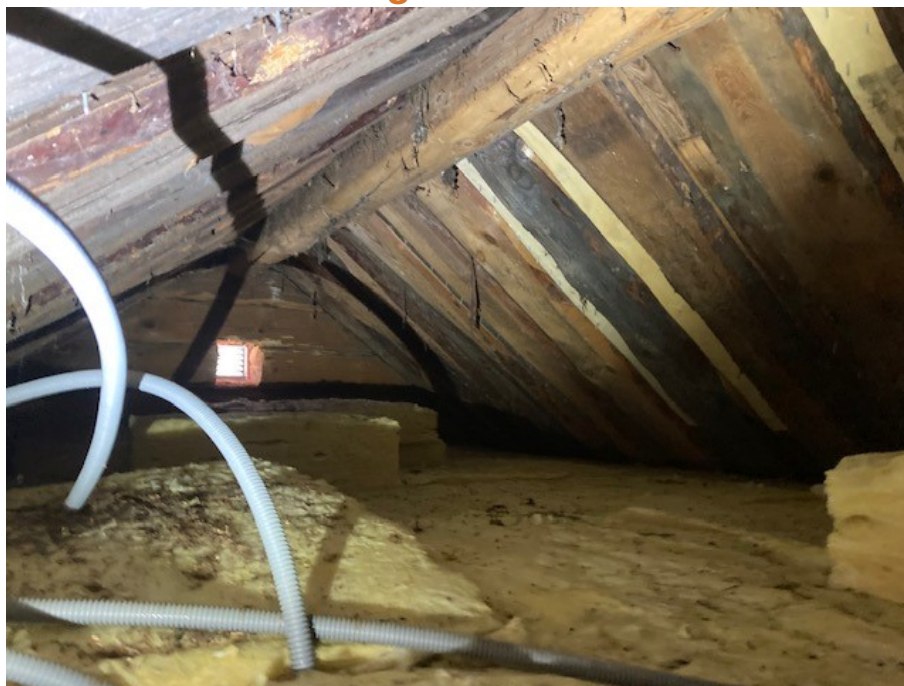
Nockvind via lucka i tak på övervåningen.
