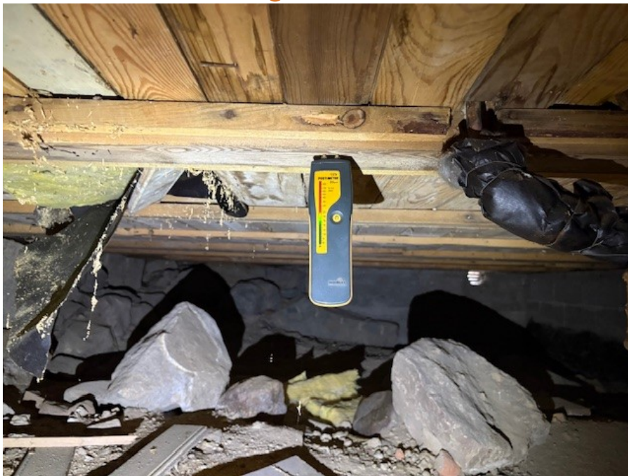
Fuktmätning i torpargrunden.
