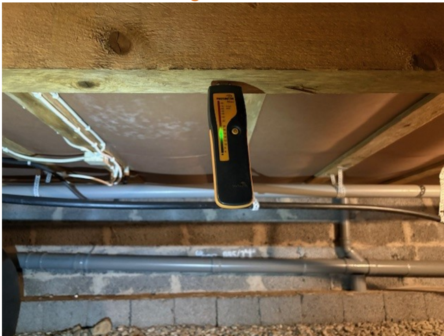
Fuktmätning i krypgrunden.
