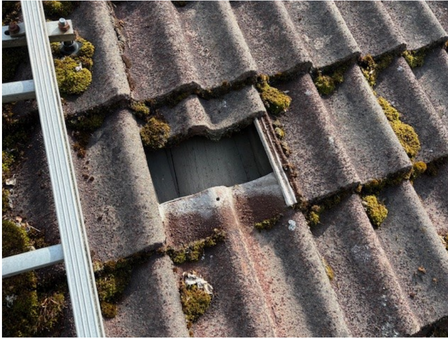
Äldre underlagstak utgörs av brädtak.
