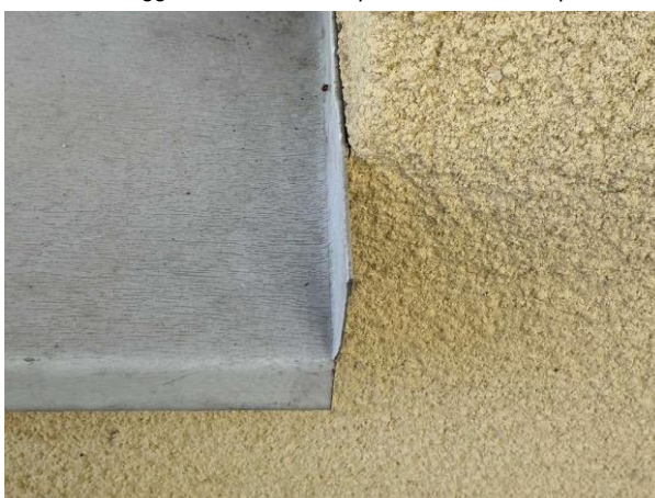
Bild 11: - Utvändigt, Fönster, Putskant saknas på fönsterbleck Fönsterbleck saknas på tillbyggnad och fönster på gavel på övre plan
