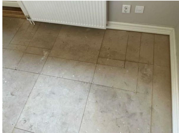
Bild 27: - Invändigt, Entréplan, Sprickor i skivskarvar tak Skivgolv ej fackmannmässigt läggning
