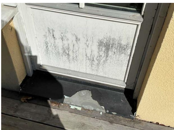
Bild 12: Utvändigt, Ytterdörr, Färgsläpp altandörrar
