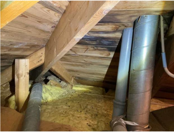
Bild 14: - Utvändigt, Vind, Parallellisolerade /snedtak se riskanalysen Hål i plastfolie noterades Missfärgad isolering not...
