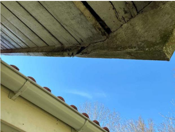
Bild 16: - Utvändigt, Yttertak, Äldre tak besiktat från taksäkerhet Rötskador i vindskivor Missfärgningar på tak saknas över takk...
