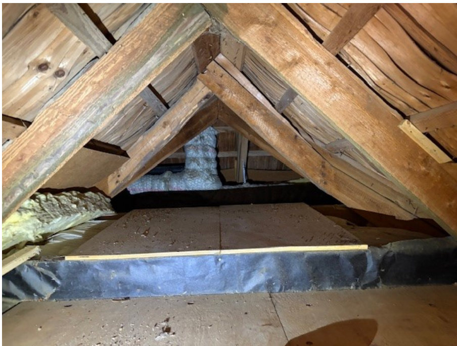
Nockvind via lucka på övervåningen.
