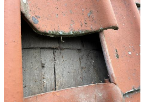
Äldre underlagstak av spån.
