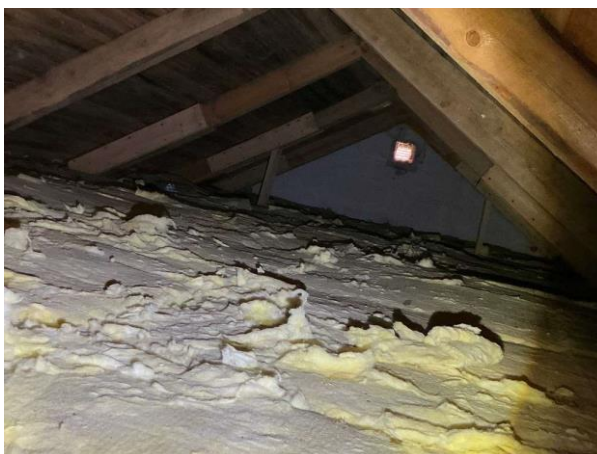
Bild 8: - Utvändigt, Vind, Vind är delvis parallellisolerad, tilläggsisolerad och fd självdragsventilerad se riskanalysen Vi...
