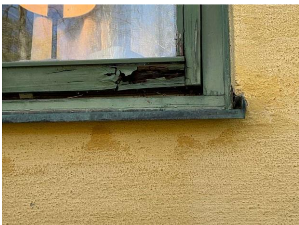
Bild 5: - Utvändigt, Fönster, Torrspäckor, färgsläpp och kittsläpp på fönster Röttskada i karmbottenstycke noterades baksidan b...
