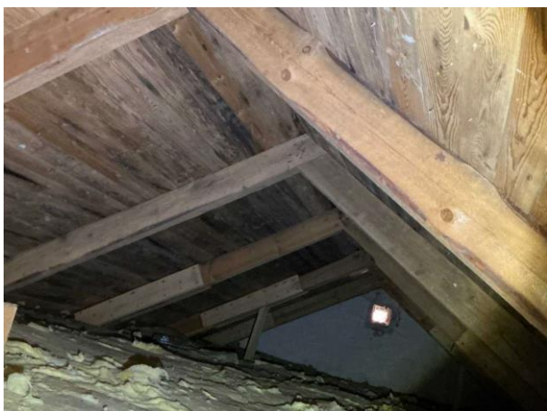
Bild 7: - Utvändigt, Vind, Vind är delvis parallellisolerad, tilläggsisolerad och fd självdragsventilerad se riskanalysen Vi...
