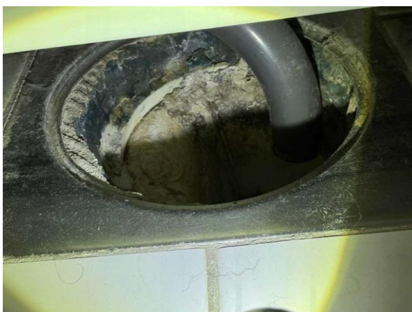
Bild 6: - Invändigt, Övervåning, Äldre våtrum se riskanalyser Det förekommer rörgenomföringar i golv för annat än avlopp Uppvikt t...
