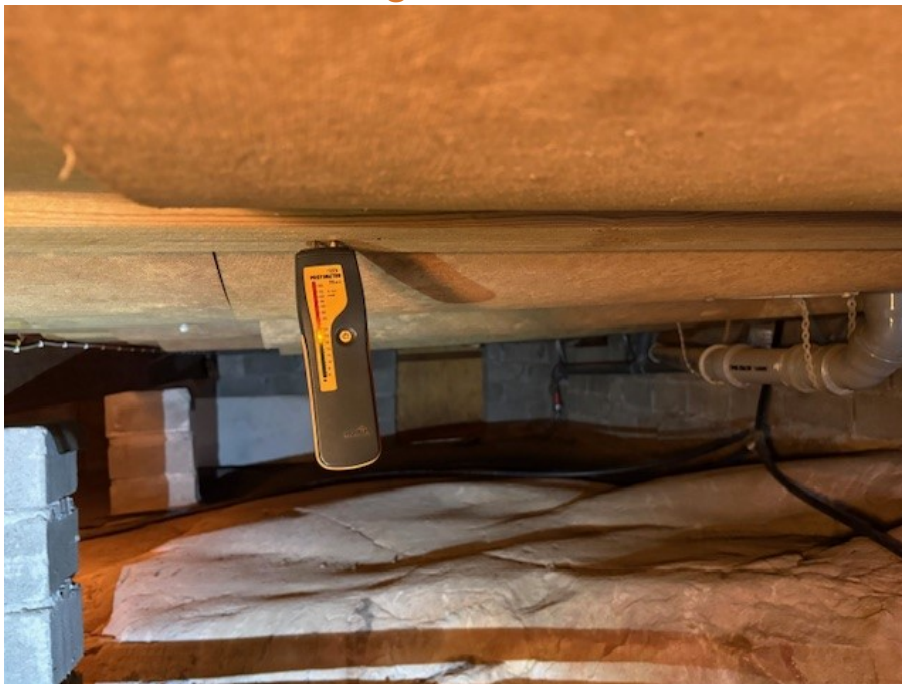
Fuktmätning i krypgrunden.
