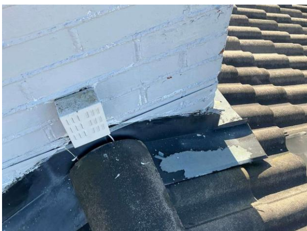
Bild 5: - Utvändigt, Yttertak, Äldre tak tätad skorstenskrans
