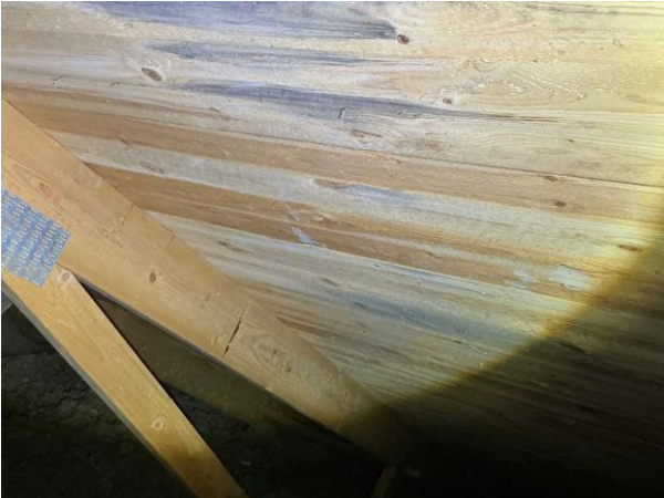
Bild 1: Utvändigt, Vind, Några blånader/missfärgningar noterades på underlagstaket (torra vid besiktningen) bör hållas und...
