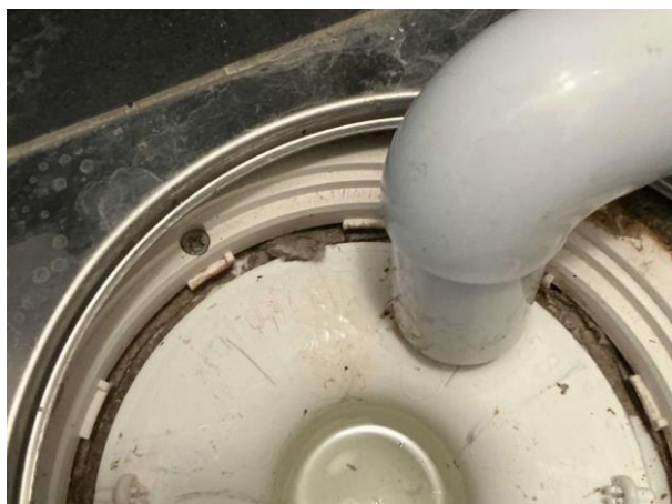
Bild 7: Invändigt, Souterrängplan, Brunnsduken är synlig under klämringen
