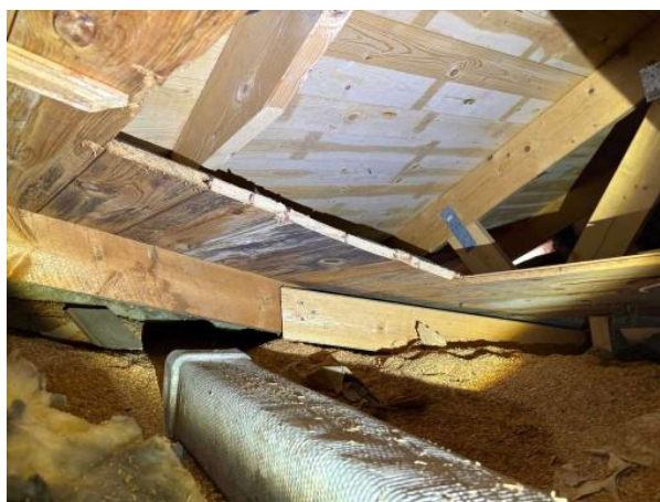
Bild 4: - Utvändigt, Vind, Huset är självdragsventilerat Parallellisolerade /snedtak (delvis saknas vindsutrymme, utgår ur b...
