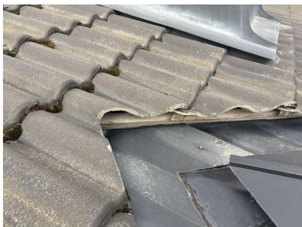
Bild 5: - Utvändigt, Yttertak, Synligt läkt i rännalden
