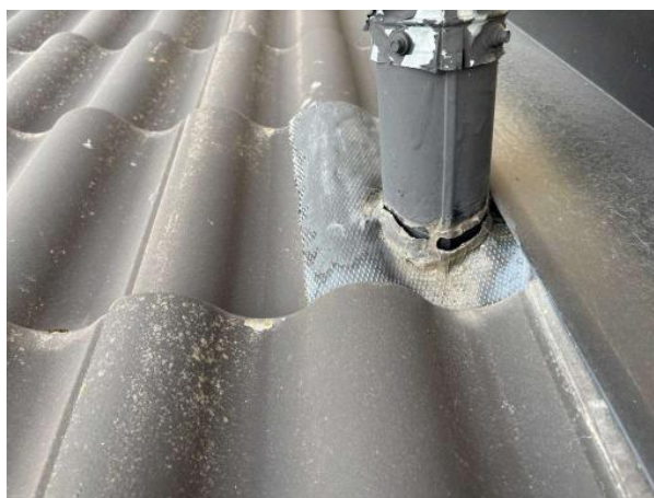
Bild 6: - Utvändigt, Yttertak, Sprucken tätning vid genomföring
