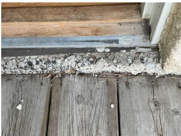
Bild 9: - Utvändigt, Övrigt, Tröskelplåt saknas till dörren S
