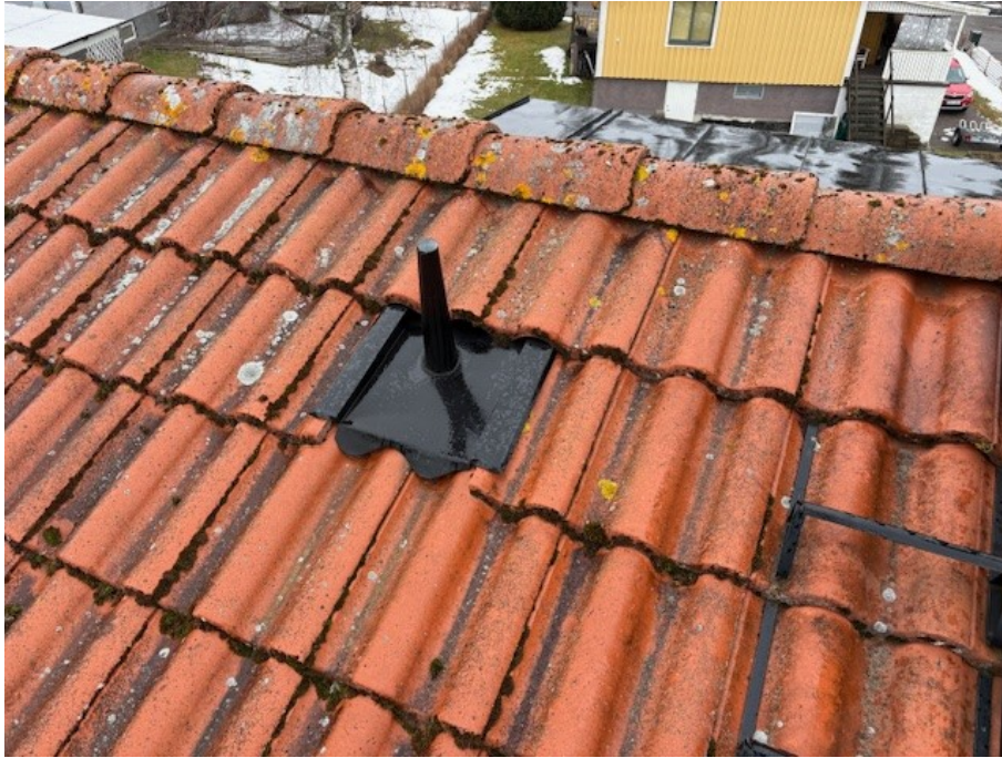
Plåtinklädnad till före detta expansionskärl, ej i bruk.
