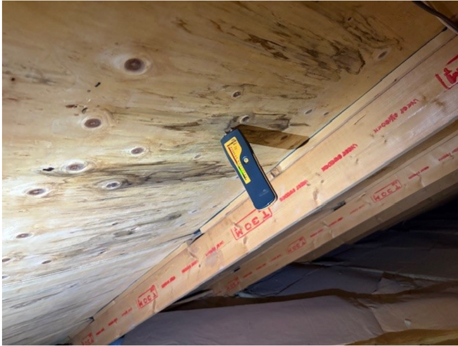
Fuktmätning på vind.
